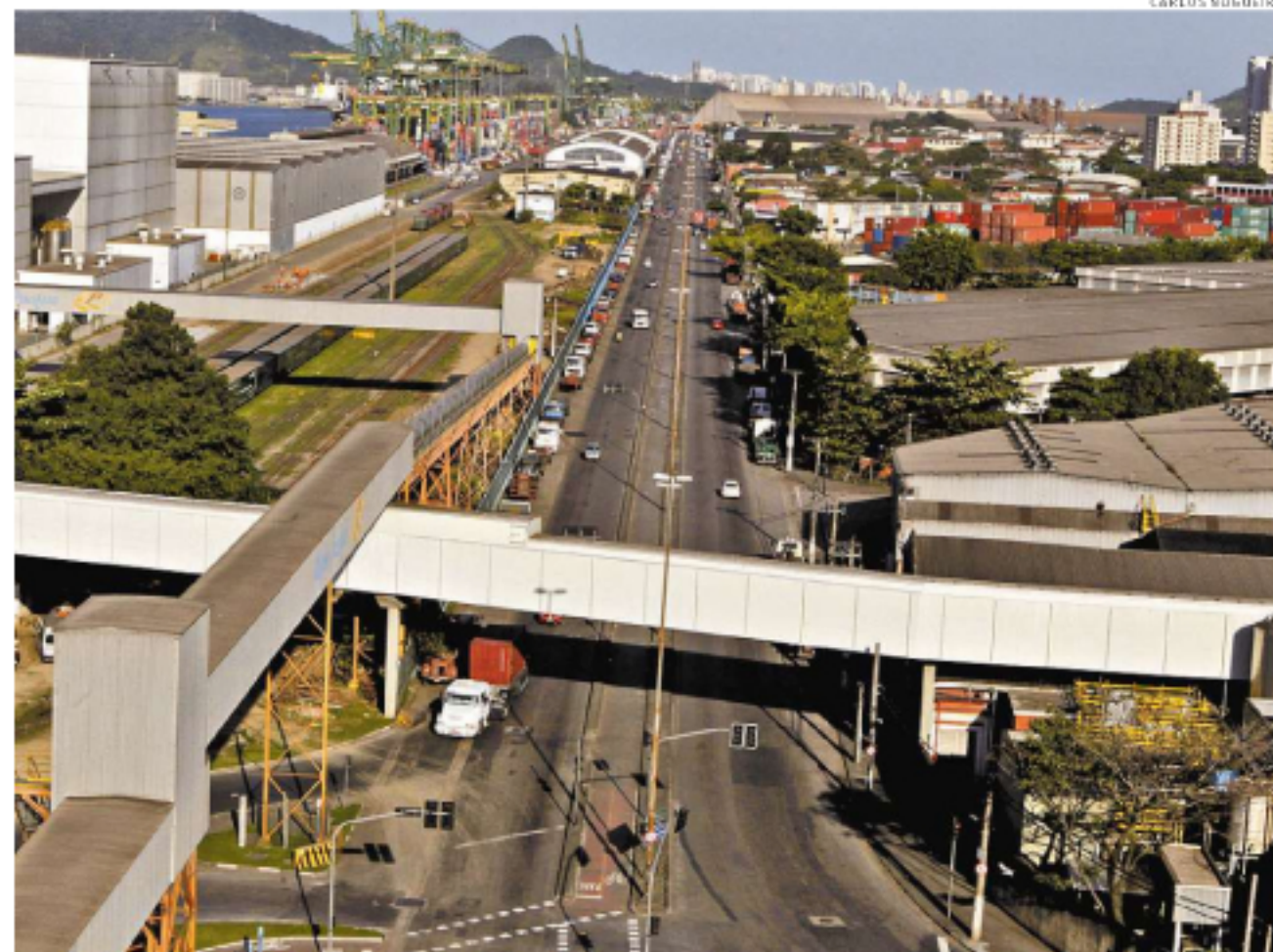
Reforma da Av. Mário Covas para implantação da Av. Perimetral é uma das próximas obras a serem feitas no Porto
