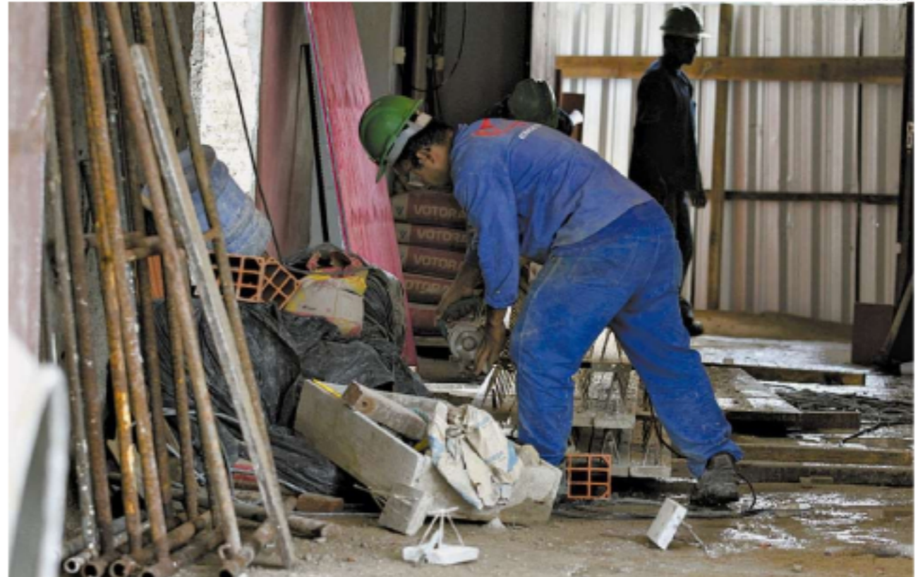
Apenas 35% da obra foi concluída e trabalhadores atuam no reforço das estruturas da ponte
