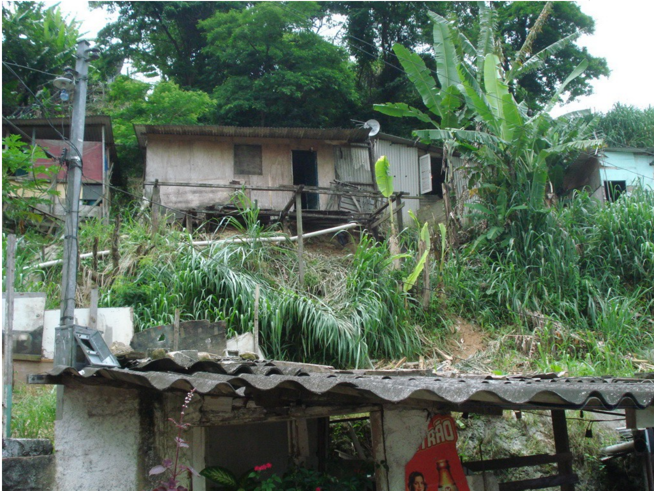
Foto FC-ST-20-01.01: Moradias de madeira localizadas próximas ao topo e a base de taludes de corte com altura elevada (Caneleira).
